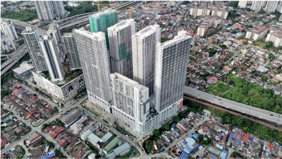
Astrum Ampang adalah antara sorotan utama projek dibangunkan oleh Kerjaya Prospek
